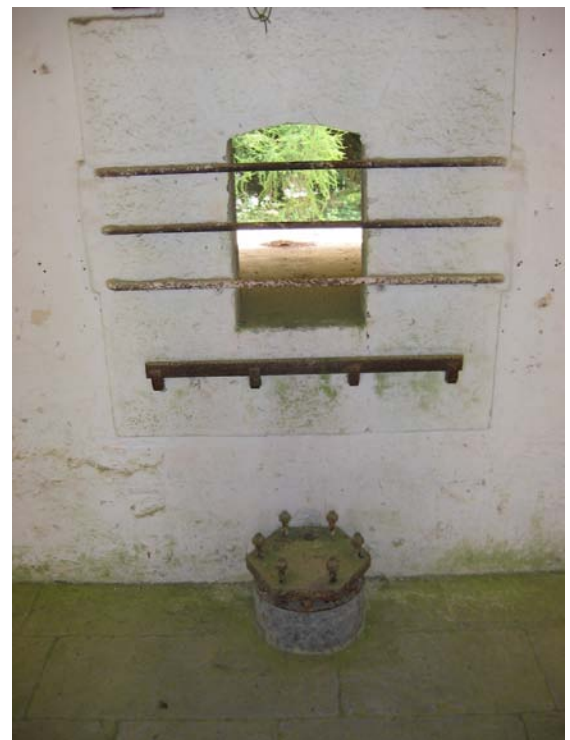
Supporto in muratura su cui si inchiodava il pilastrino in ghisa per mitragliatrici Gardner. Nava, Forte Centrale.
