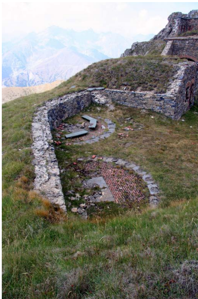
Piazzola doppia per pezzi affiancati. Notare il pavimento in mattoni di coltello Forte Pepino, Colle di Tenda.
