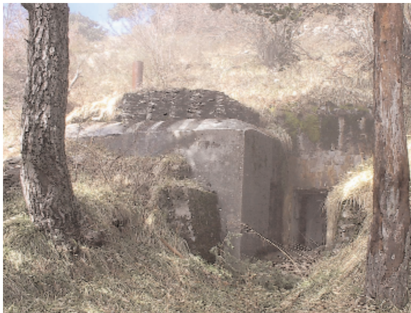
Uno dei blocchi d'ingresso della 604ª batteria
