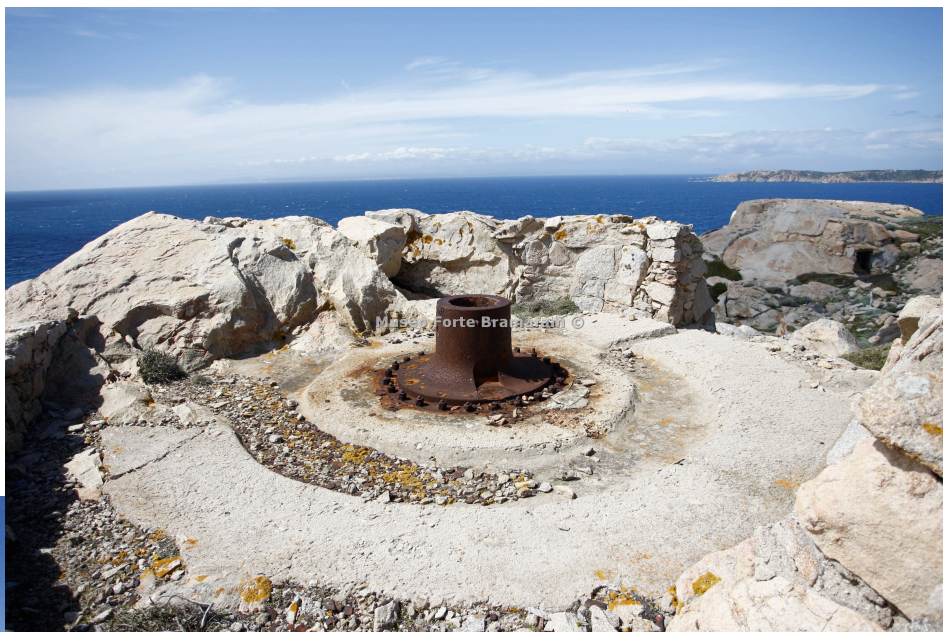
Postazione con basamento per cannone per tiro illuminante
