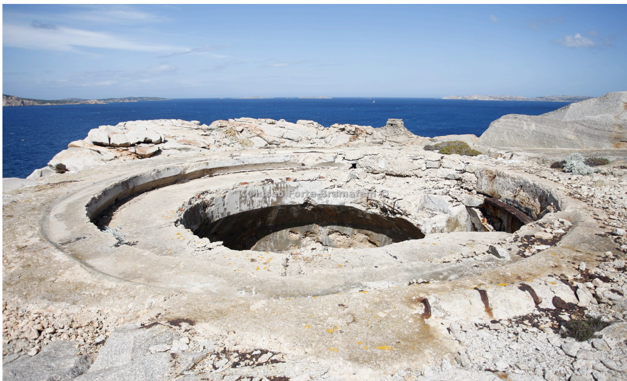
Il pozzo della seconda installazione da 203/45
