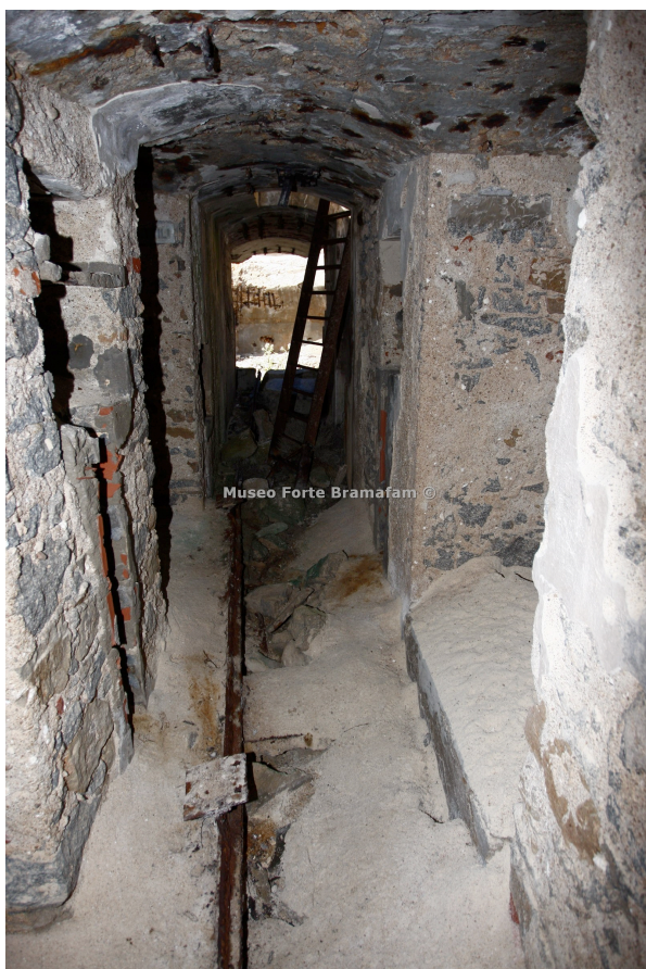
Galleria d'accesso al primo pozzo da 203/45 con resti delle rotaie di una decauville
