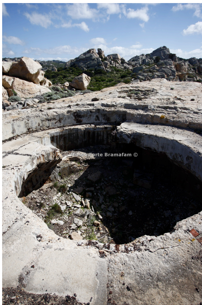
Pozzo di una delle due installazioni da 203/45 mascherata con rocce granitiche
