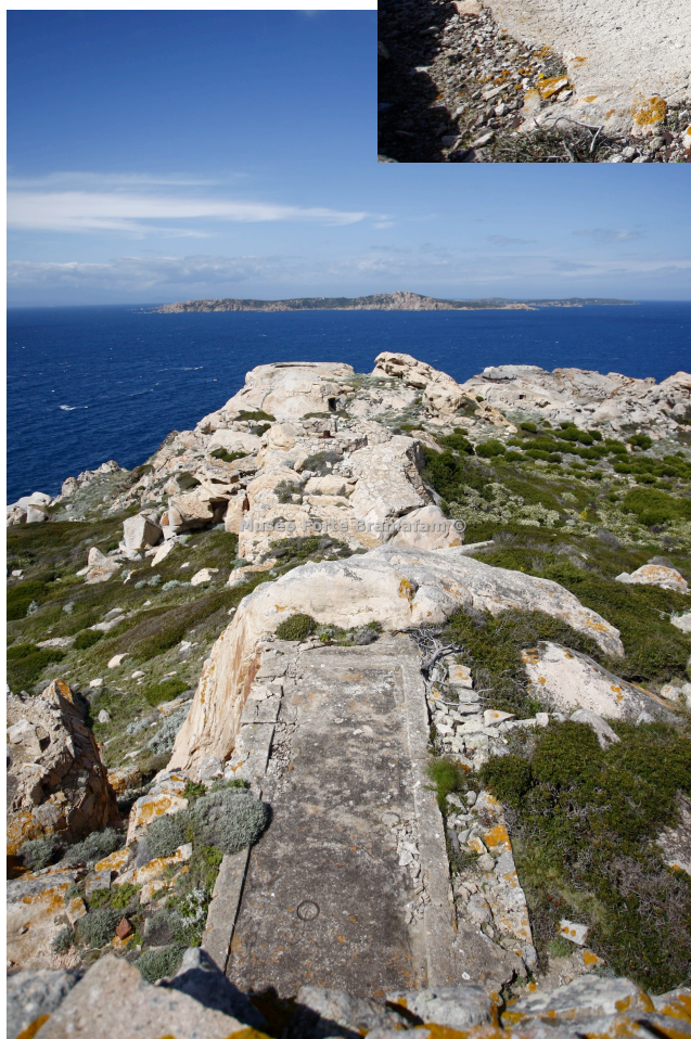
Il complesso della batteria dalla postazione del faro
