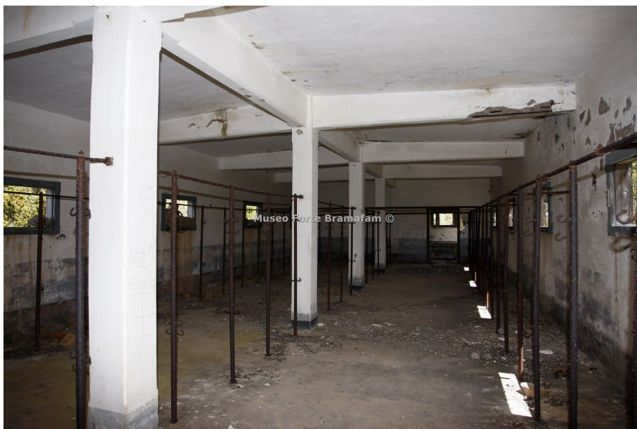
Interni della camerata truppa con ancora in sito i supporti delle brande
