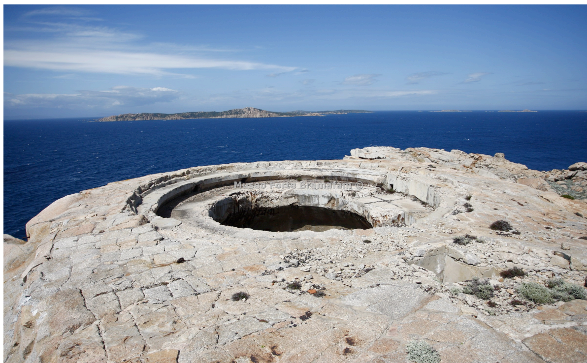
Pozzo di una delle due installazioni da 203/45 mascherata con rocce granitiche
