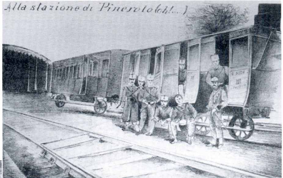
1892. I cadetti alla stazione di Pinerolo in attesa di salire sulla carrozza che li riporterà a Torino.
