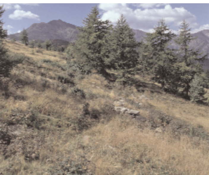
Fronte ovest: tratto degradato con il muro in pietra a secco
