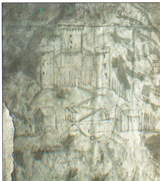
Particolare della figura di pagina 15: si può vedere il forte ancora incompleto nella sua costruzione.
