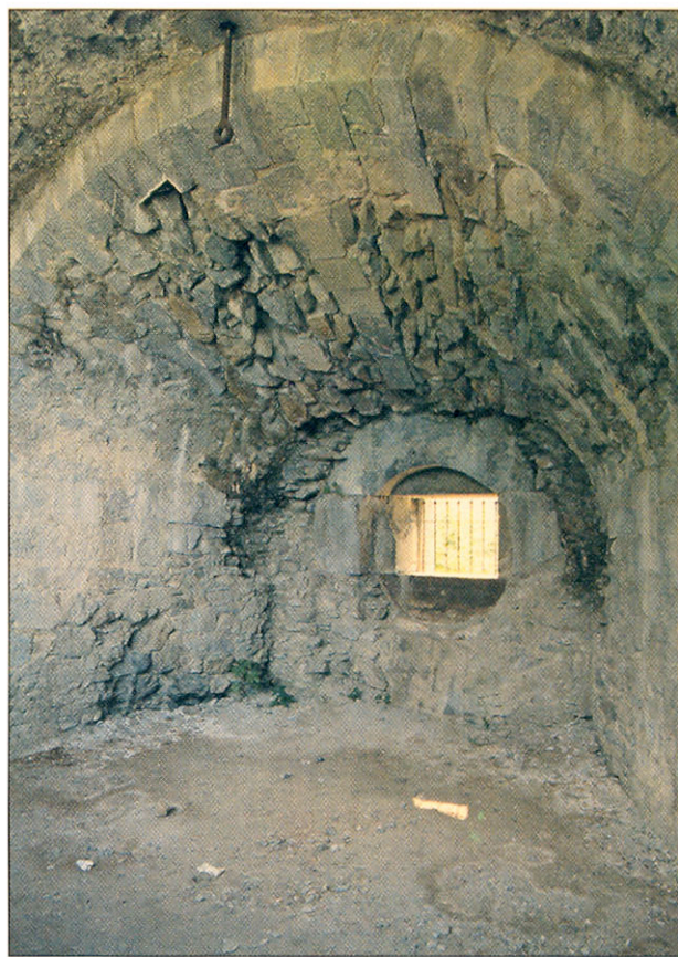
Forte di Vinadio, interno di una casamatta a sfera.
